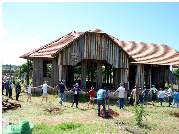
O HOTEL ROLÂNDIA FOI DEMOLIDO E AGORA VEM SENDO RECONSTRUIDO COM SUA MADEIRA ORIGINAL EM OUTRO LOCAL.
